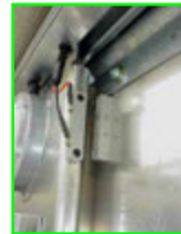
Bulkhead Door Switch
